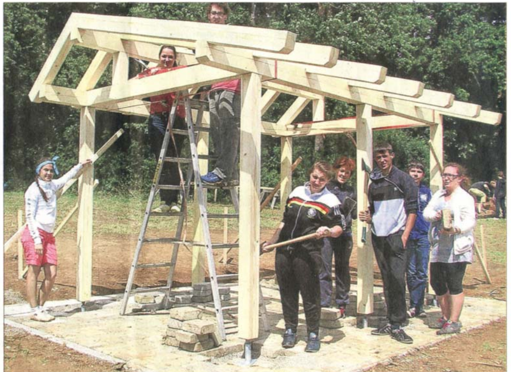
Nach der schweißtreibenden Arbeit wurde nun Richtfest an der Grillhütte gefeiert.
